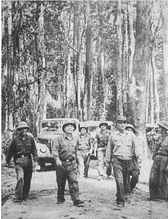
Đại tướng Võ Nguyên Giáp (hàng đầu đi giữa) đang thị sát đường Trường Sơn, bên trái là Tư lệnh đường Trường Sơn Đông Sĩ Nguyên, bên phải là Cục trưởng Đặng Tĩnh
